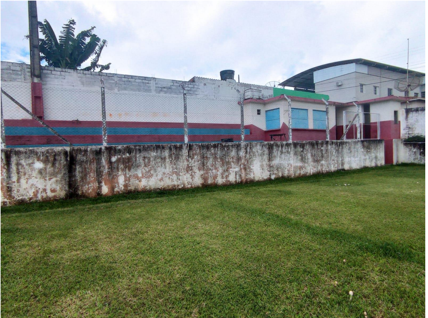
Foto 03: Arquibancada (entrada) - Local da execução da cobertura.
