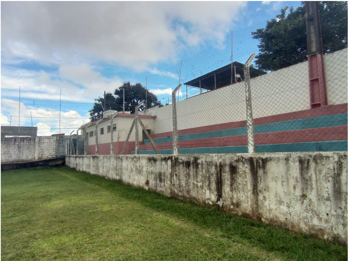
Foto 02: Arquibancada (banheiros) - Local da execução da cobertura.
