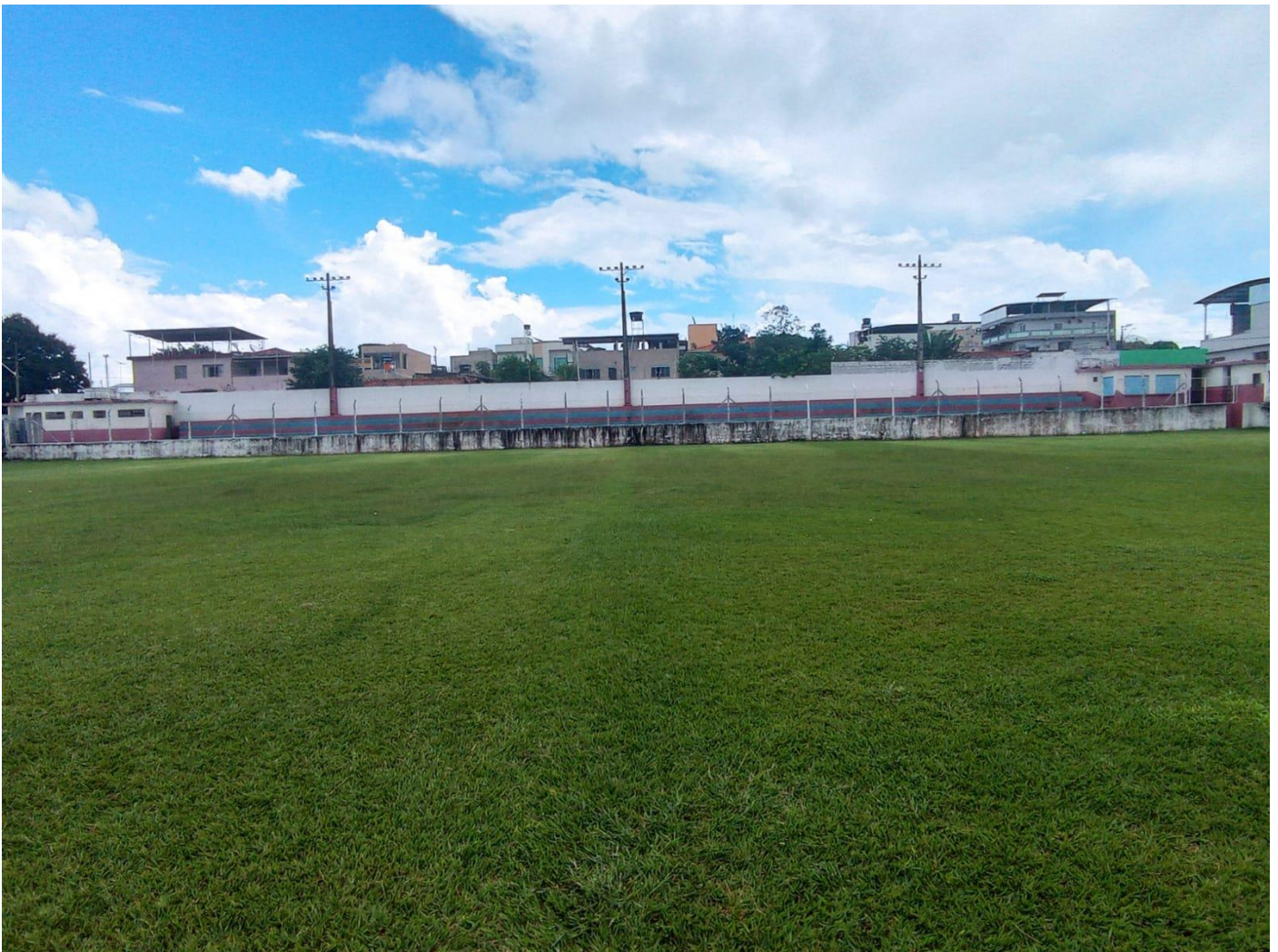
Foto 01: Frente da arquibancada - Local da execução da cobertura.
